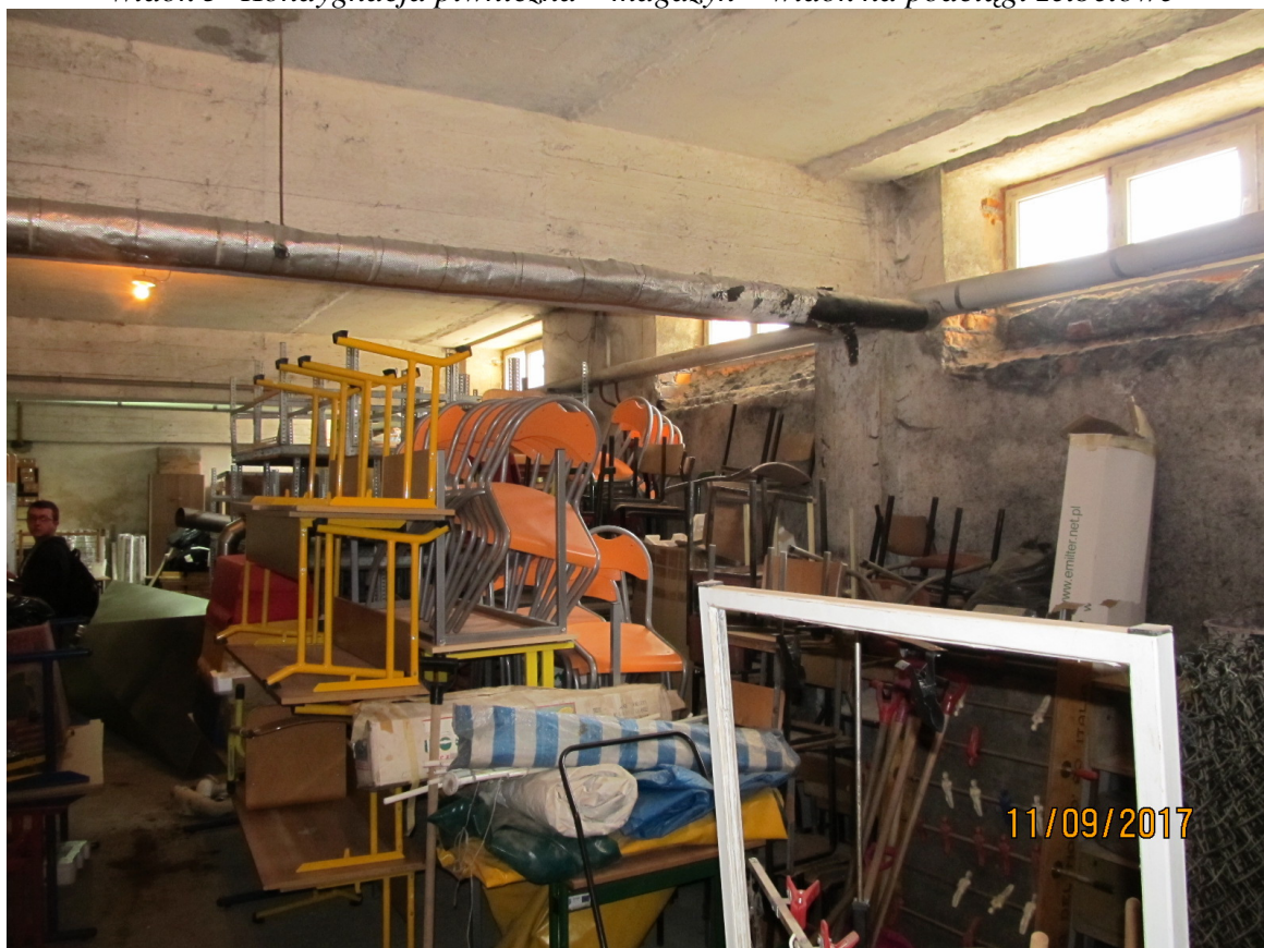
Widok 5- Kondygnacja piwniczna – magazyn – widok na podciągi żelbetowe
