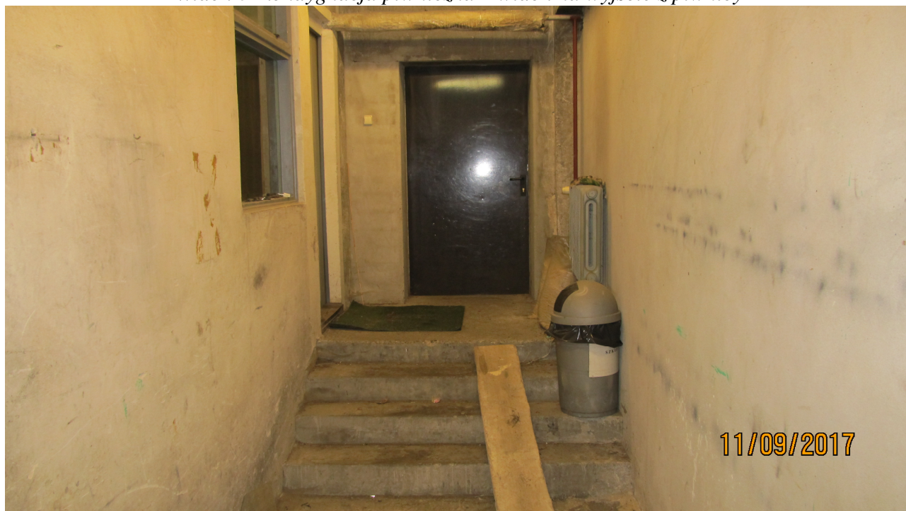
Widok 6- kondygnacja piwniczna – widok na wyjście z piwnicy
