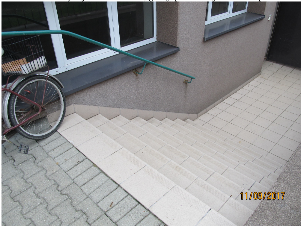
Widok 3- Schody zejściowe do kondygnacji piwnicznej – do zabezpieczenia.
