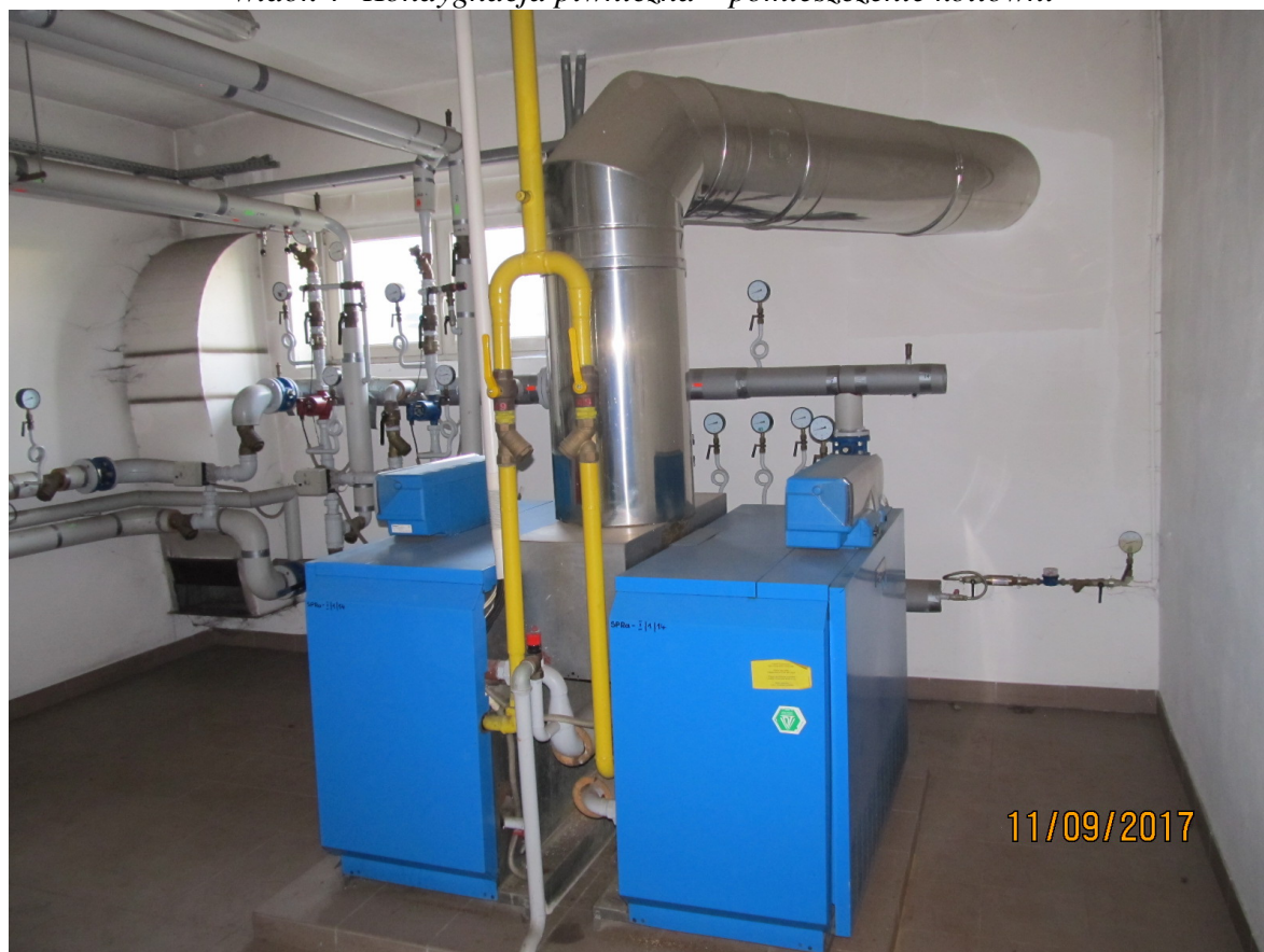
Widok 4- Kondygnacja piwniczna – pomieszczenie kotłowni
