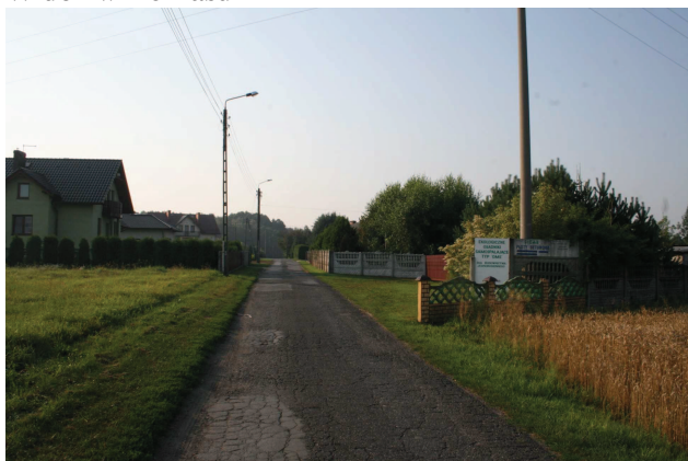
ZDJ 5 ul Bartnicza ok. km 0+220 Widok w kier lasu
