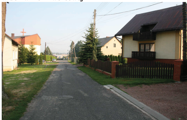
ZDJ 4 ul Bartnicza ok. km 0+150 widok w kier Dworcowej
