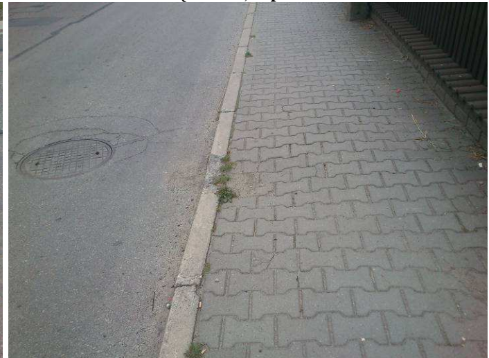
ZDJ 12 Uszk. Krawężników, zapadliska
