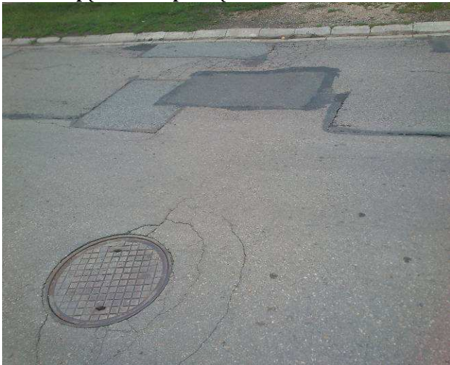
ZDJ 11 Spękania i zapadnięcia w ok. studzienki kd
