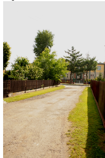
Zdj 6 Ul. Drozdów km 0+300
