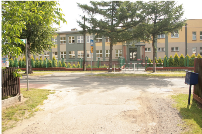
Zdj 7 Wlot do ul Woszczyckiej km 0+310
