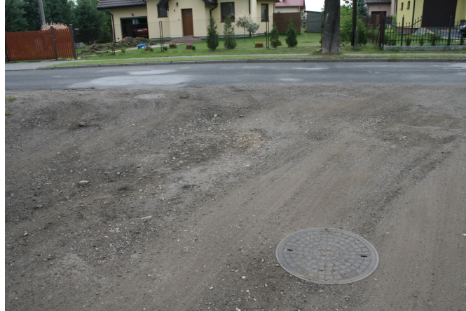
Zdj 8 Wlot do ul. Woszczyckiej km 0+010
