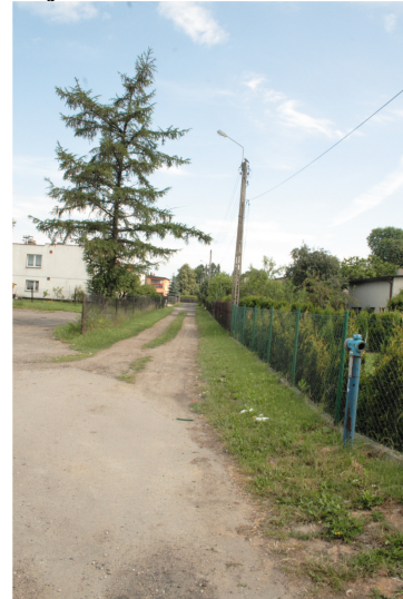
Zdj nr 3 ul. Drozdów ok. km 0+150
